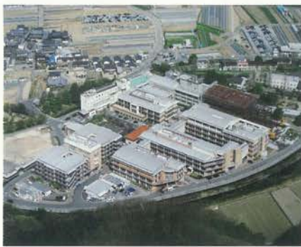
建設中の旭川荘療育・医療センター（敷地右奥）
