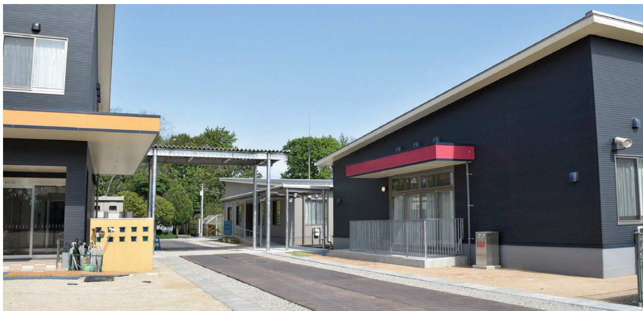
わかば寮建て替え第Ⅱ期工事で完成した管理棟(中央奥)と居住棟(右手前)
