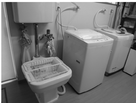
(4) 洗濯機の横に汚物処理用の流しを完備
