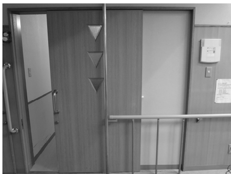
（3）手すりの設置された居室入口
