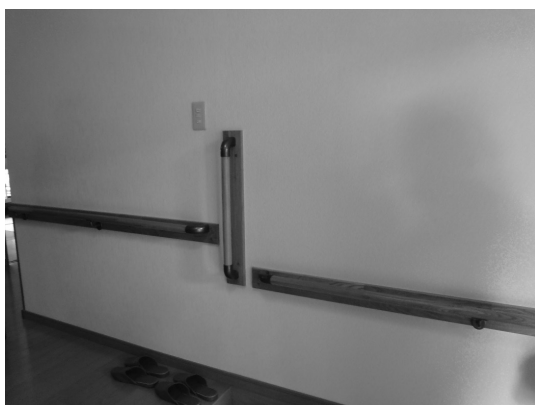
(3) 手すりの設置されている廊下
