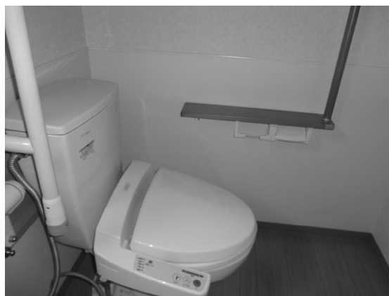
(5) 手すりを完備しバリアフリー構造のトイレ
